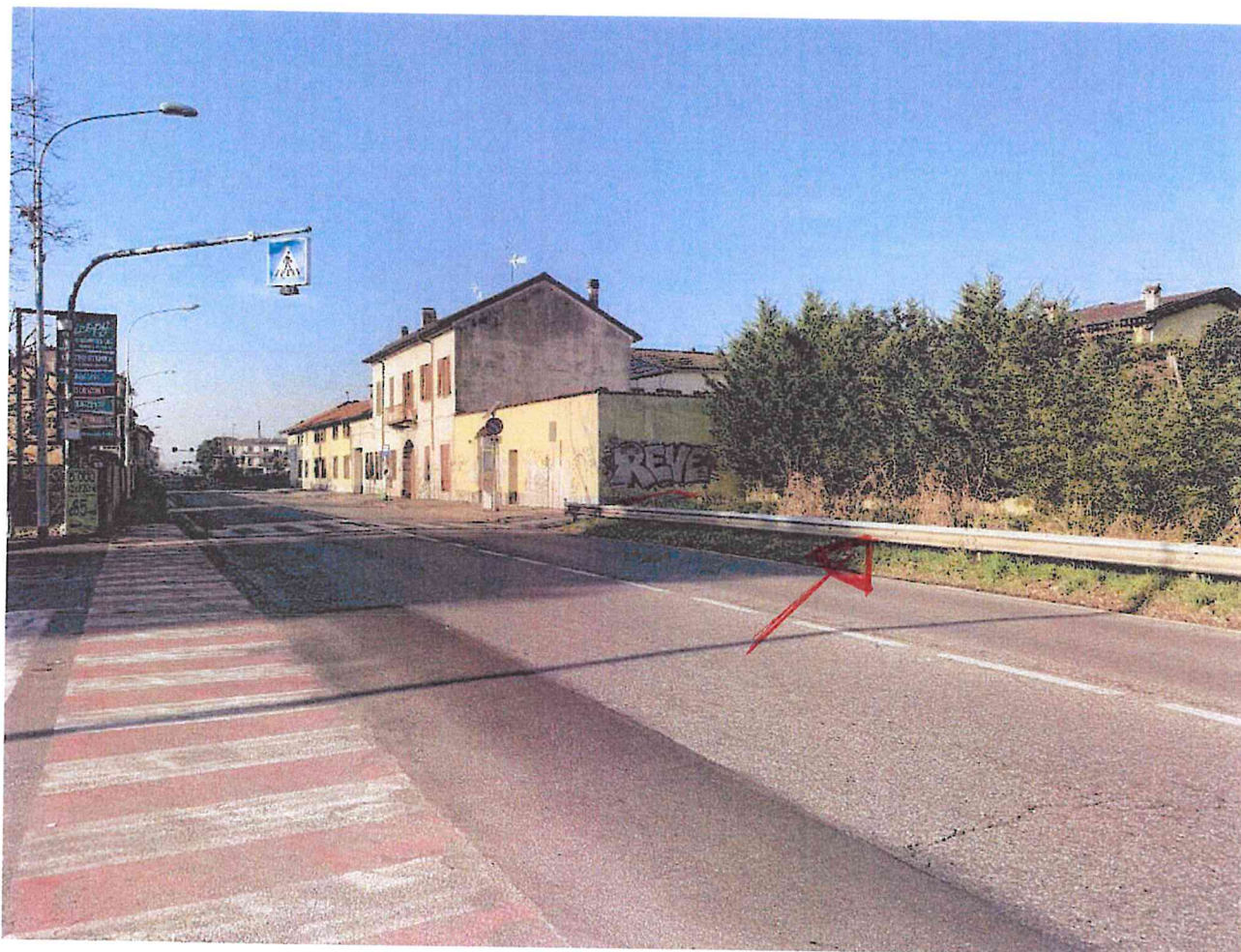
VISTA GENERALE DELLA STRADA VERSO LA FRAZIONE DI VILLA FORNACI
